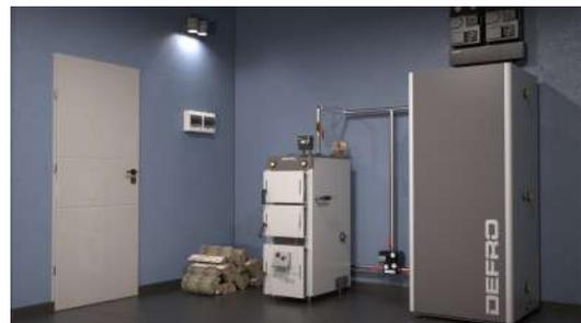
Der Kesselaufbau und der elektronische Feuerzugsregler machen aus diesem Klassiker einen modernen Naturzugvergaser für Scheitholz und ermöglichen wirtschaftlich zu heizen. Die elektronische Steuerung für die Primärluftzufuhr kann aber noch mehr. Sie kann auch die Kesselkreispumpe und ein optionales Saugzuggebläse ansteuern.
